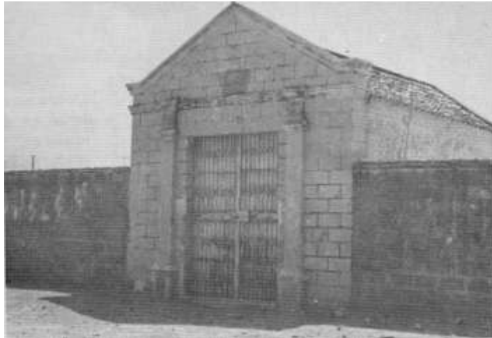
5. Fachada del cementerio judío de Coro, 1968, antes de su restauración.
