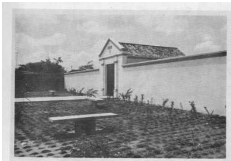
11. Entrada al cementerio después de su restauración.
